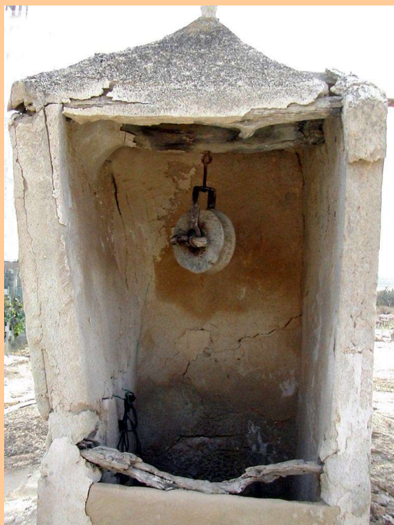
Capilla a cuatro aguas, brocal de losa y garrucha de madera –la mayoría la tienen de hierro– sobre palo de olivo. Los Manchados.
