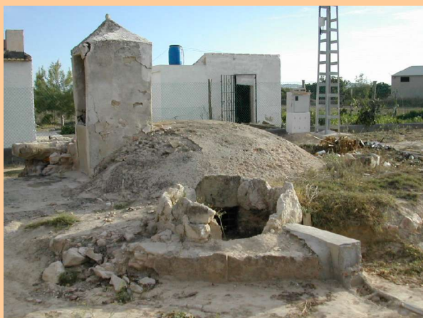
Aljibe de bóveda con recibidor adosado (en primer plano). Los Manchados.
