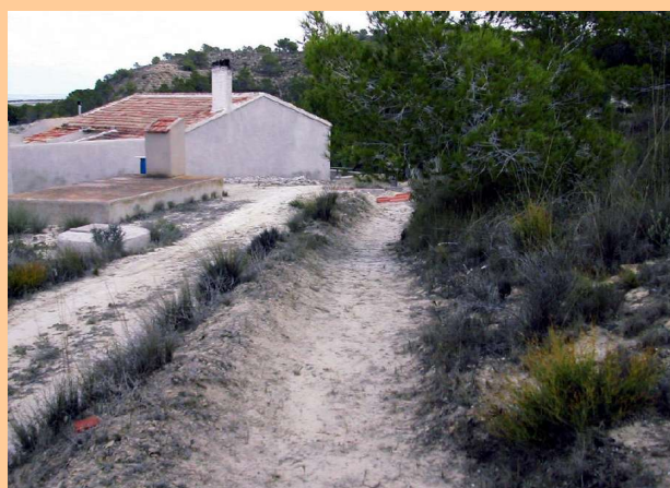
Boquera a pie de monte para canalización del agua de lluvia hacia el recibidor y el aljibe. Tía Dorotea.
