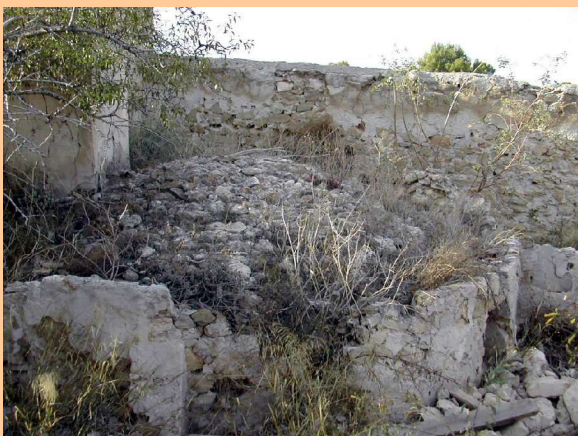
Bóveda semiesférica de piedra por aproximación de hiladas en el aljibe de Lo Zafra.
