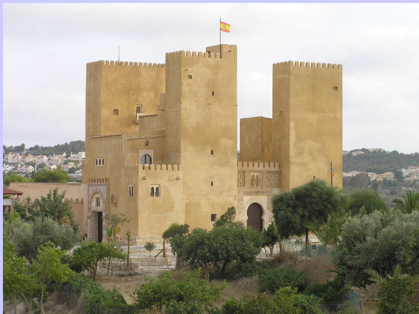
Antigua fábrica de yeso, hoy reconvertida en un edificio singular
